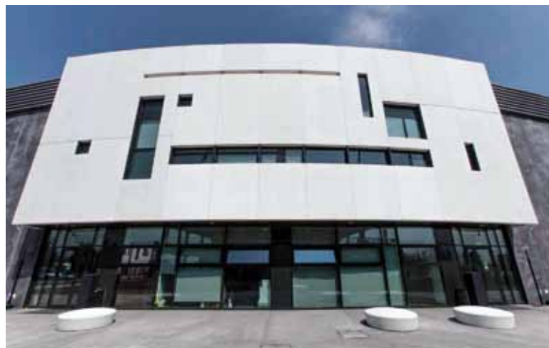
Il data center realizzato da Data4 per IBM Softlayer
